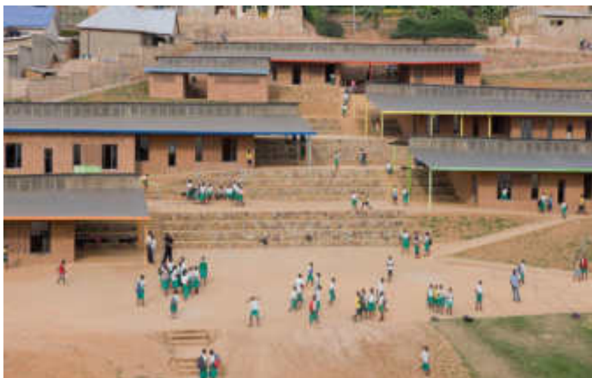
Fig.35 - École primaire d'Umubano, Mass Design Group, Kigali, Rwanda, 2010
