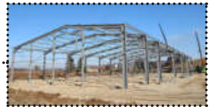
Structure métallique agricole détournée
