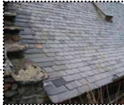
Enveloppe en ardoise de récupération
