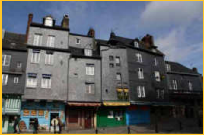
Continuité matérielle de l'enveloppe minérale 'murs-toit'- Honfleur (Calvados)
