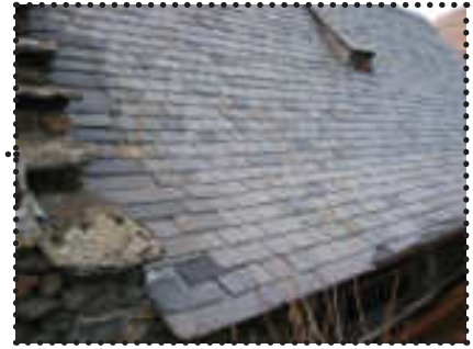
Enveloppe en ardoise de récupération
