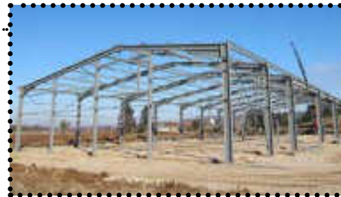
Structures métalliques détournant savoir faire des entreprises locales constructions agricoles
